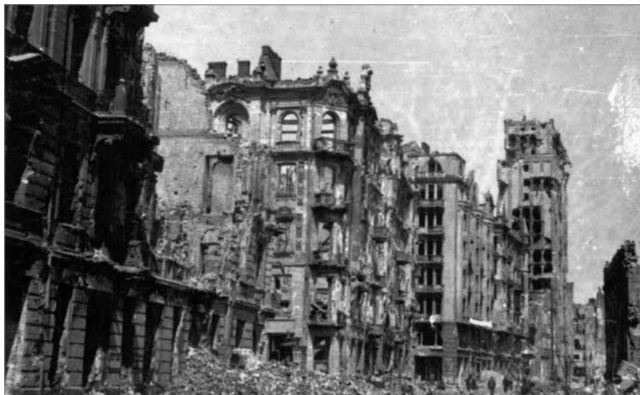
» Ruiny na ul. Brackiej
